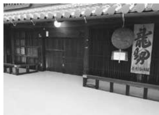
玄関の浸水時の様子
